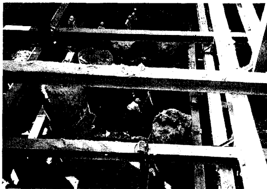
그림 1-2. Baiyoke II 기초공사현장 장면
