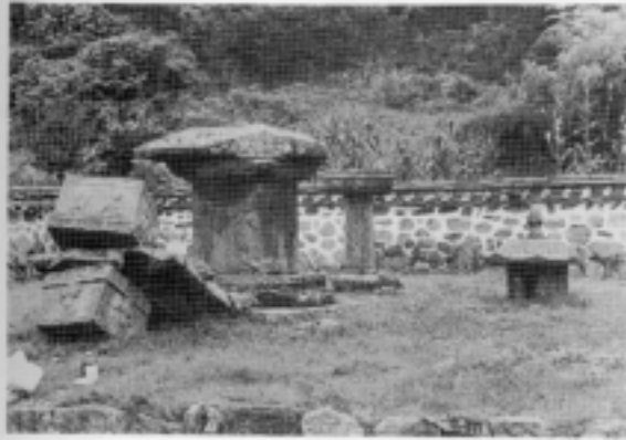
사진 1. 국보 13호 실상사 백장암 3층석탑이 인위적인 요인으로 파손된 상태
