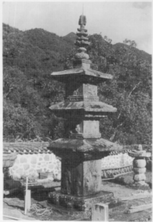
사진 2. 에폭시계의 한성수지로 파손된 면을 복원하여 조립하여 놓은 상태
