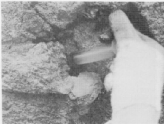
사진 6. 균열된 부위를 주사기를 사용하여 예폭시 수지를 침투시켜 집착시키는 상태
