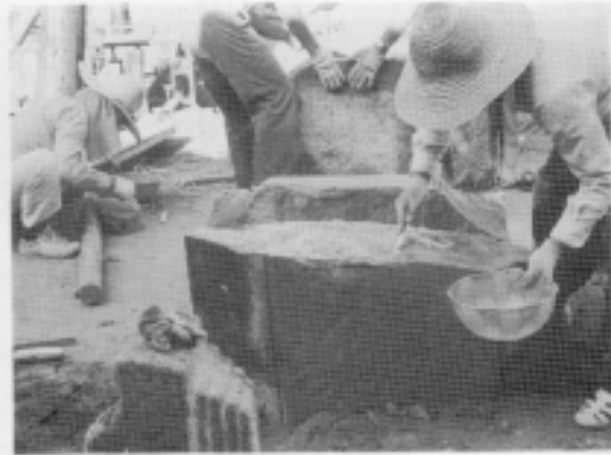
사진 7. 보물 395호 선암사 3층석탑의 파손부위를 집착시키기 위해 수지를 접착면에 바르는 상태
