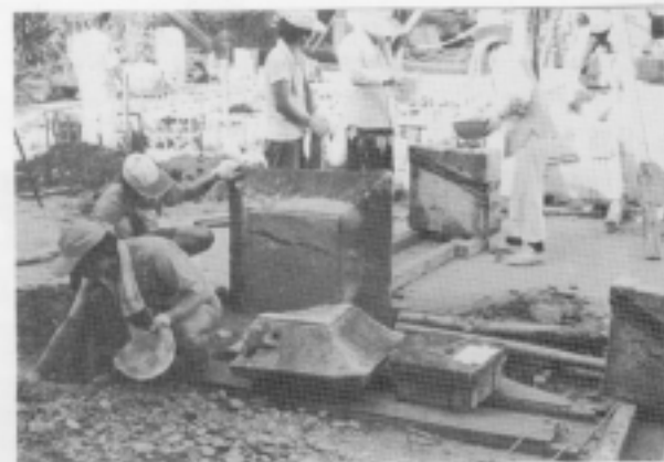
사진 8. 예폭시 수지로 집착시키고 고무로프로 잡아매어 고정시켜 놓은 상태
