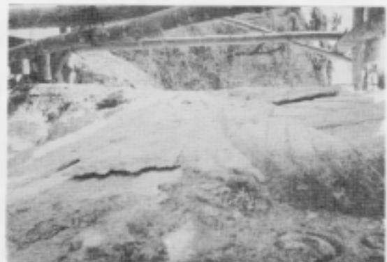
사진 5. 보물 581호 골굴암 마에여래좌상의 표면이 균열되어 이탈되고 있는 상태
