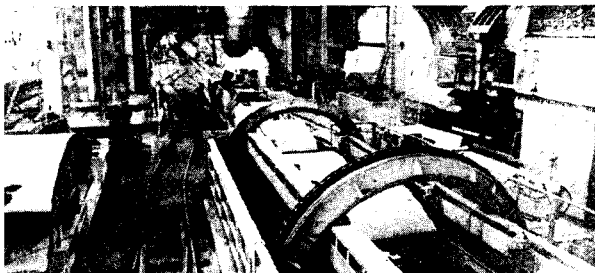
사진1. 프랑스측 상갓트 工事基地大立坑의 底部
