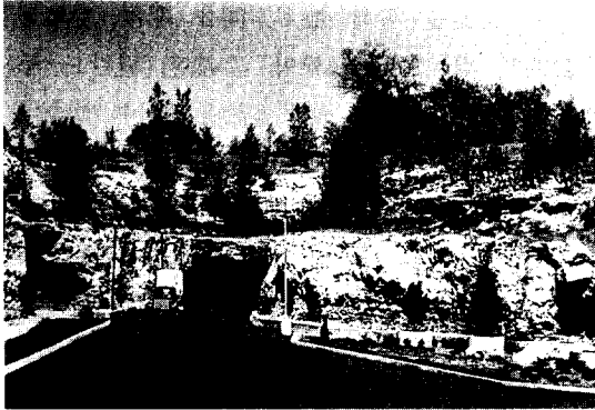
Fig. 7 지오스페이스入口터널(미국, 캔사스)
