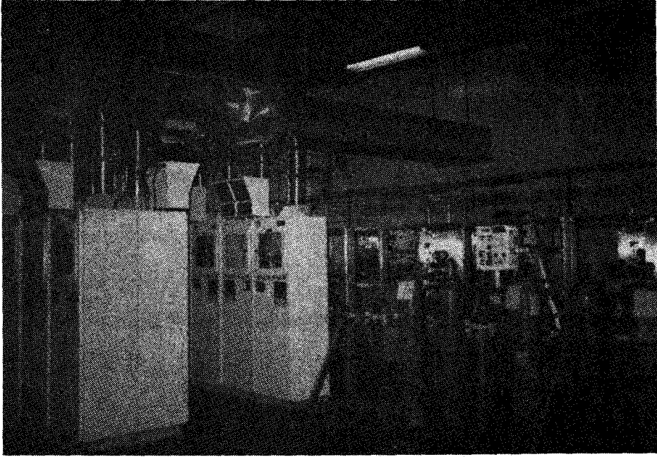
〈사진 5〉 Toxic Gas를 공급하는 GAS CABINET의 모습. 내부에 CYLINDER가 장착되며, 상부에는 STS 배기 DUCT의 모습이 보인다.
