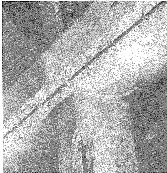
사진-3 火熱에 의한 材料의 熱膨脹差로 인한 損傷
