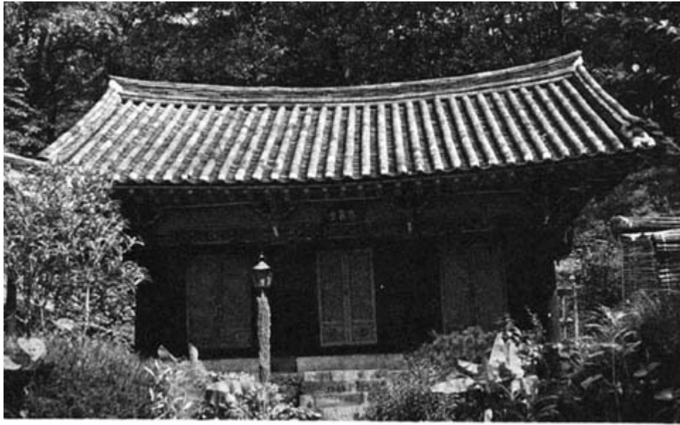
〈圖 1〉 송광사 응진당 전경 〈圖 1〉 송광사 응진당 전경
