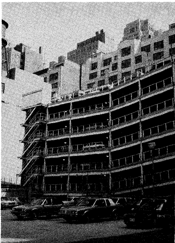
▲ 도심진입 지하철역 부근에 있는 주차장 빌딩. 지하3층, 지상7층의 이 건물엔 약 800대의 차를 주차시킨다고...
