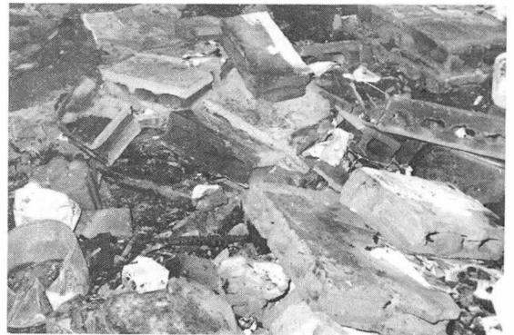
〈사진1〉가스폭발로 Apt. 벽이 도괴된 사진이다. 자기연소성의 고체가연물질은 급속연소시 파괴양상이 가스연소양상보다 예리성을 보이는 것이 다르다.
