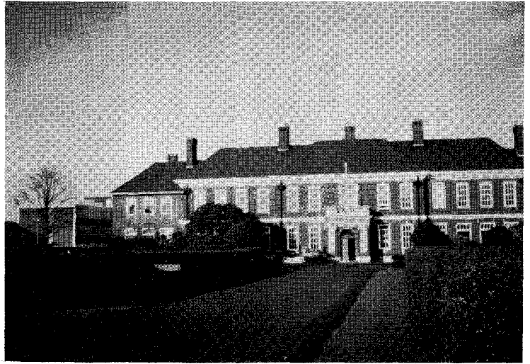
▲ 1917년에 건축된 영국 중앙수의학연구소(CVL)의 구관 본관건물. 1층에 소장실, 행정실, 도서실구관과 번식질병 연구실이 자리잡고 있으며, 2층에 영점실, 타자 및 복사실 그리고 번식질병 특수연구실들이 들어있다.
