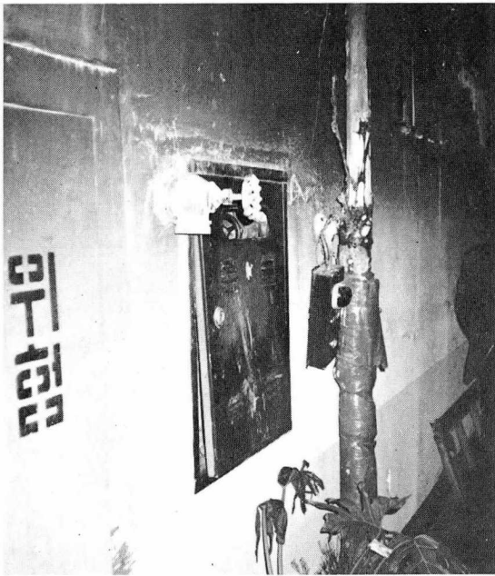
화재시에 전혀 사용되지 못한 옥내 소화전(좌)과 자동화재탐지설비의 발신기(우)
