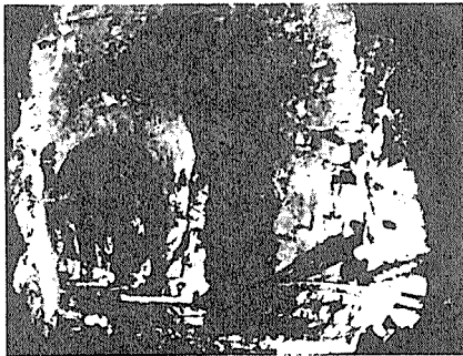
그림 14. 터널을 섬유콘크리트로 Shotcrete 하는 장면
