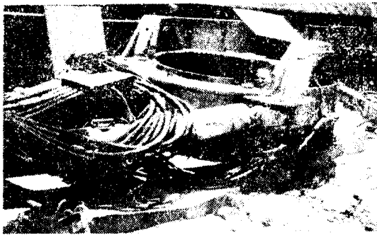
Fig. 7. CASING 근입과 일반용 OSCILLATOR (Hydraulic operation 무게 30 ton)
