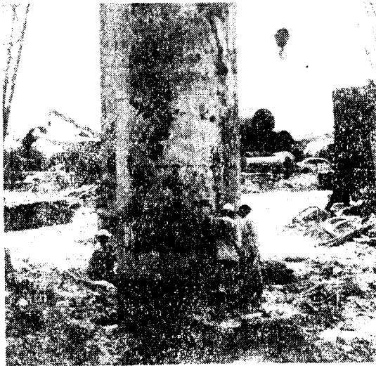
Fig. 4. 깊이가 40 m 이상되는 CASING 은 마찰력을 줄이기 위해 직경이 다른 DOUBLE CASING 이 설치된다.
