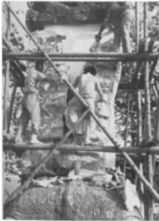
〈사진 11〉 合成樹脂를 除去하는 場面
