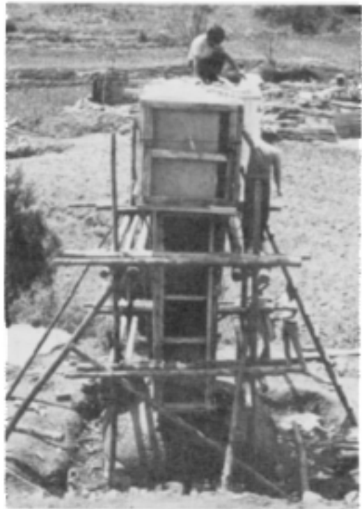
<사진 6> 二重保護틀 製作이 完了된 螭首와 碑身에 발포성 우레탄 樹脂를 부어 고정시켜 놓은 狀態
