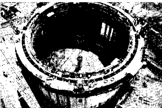
原子力發電所建設
