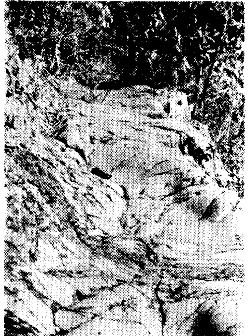
〈사진 2〉 串甲遷棧道の 路面: 高麗太祖 때 건설된 이 棧道の 난간은 모두 소멸되었다. 路面은 매끄럽게 닳아 있다.
