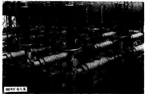
< 362 KV G. I. S >
