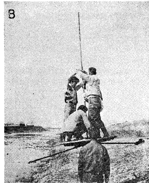
Photo. 1 Empier 試錐에 의한 探查(A. B)
