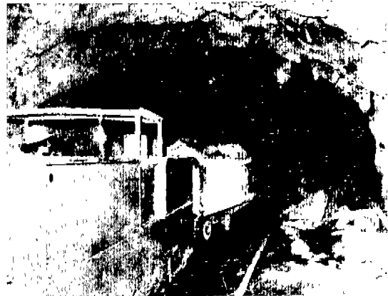
〔사진 4〕 放水터널內 버럭 搬出 光경
