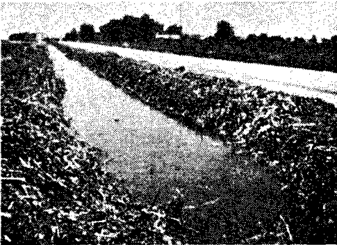
사진-5. 잡초가 번무하는 토공수로와 라이닝 수로의 모습
