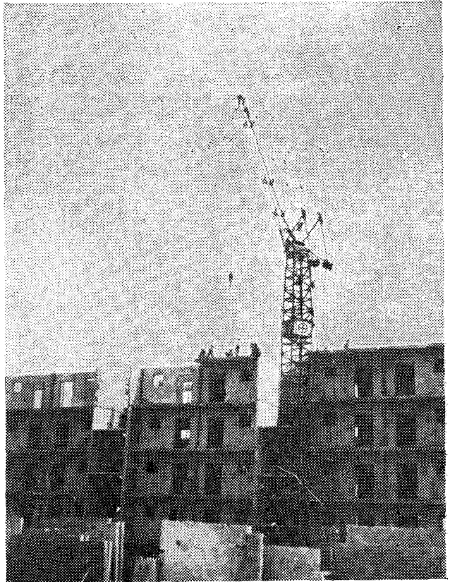
tower crane으로 끌어 올려진 P.C 판이 조립공에 의하여 조립되고 있다. 이 크레인은 현재 5층 아파트까지 사용 가능하다.
