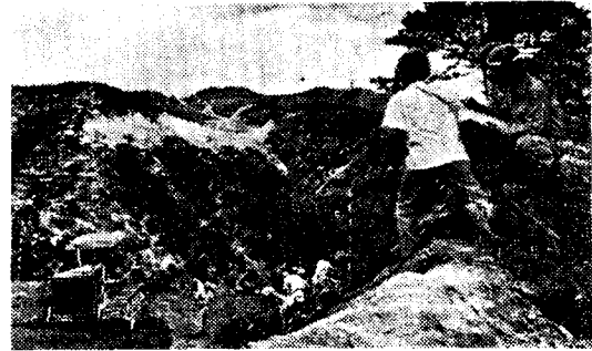
<安東댐 移設 道路工事 光景>
