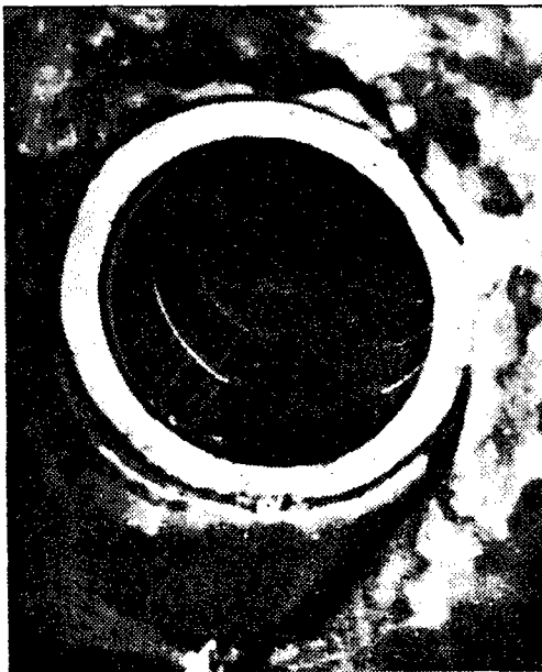
사진 5. 단위길이(1m)에서 집수유하되는 광경 (φ400mm 조립식 집수관)
