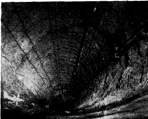
寫眞 4. 掘下作業中
