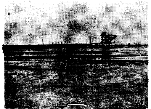
第 2 號 防潮堤施 No.23~No.25 區間 濶棧橋 架設光景 65. 7. 30
