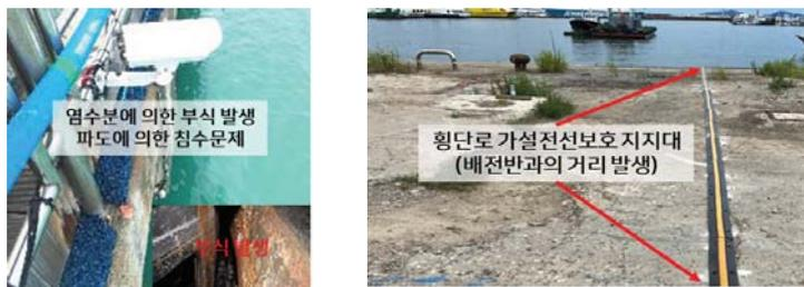
그림 1. 전기식 센서 설치 및 유지관리 시 문제점
