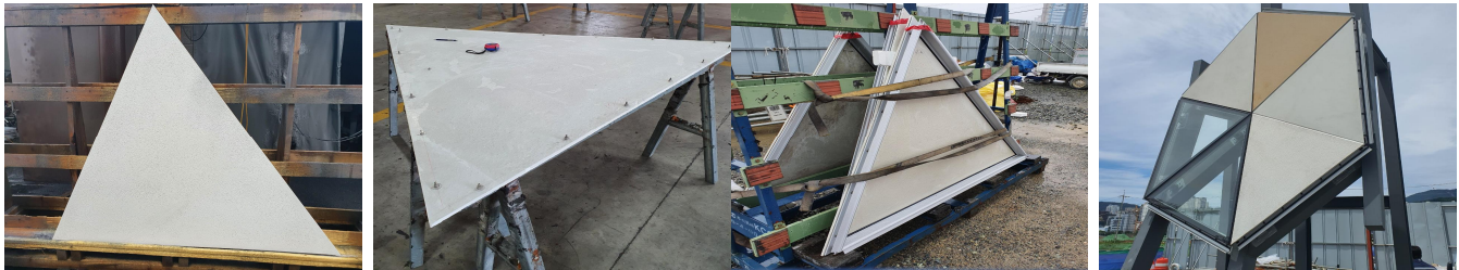
그림 3. UHPC 외장재 생산 및 현장설치
