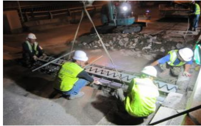
교량 신축이음 교체
