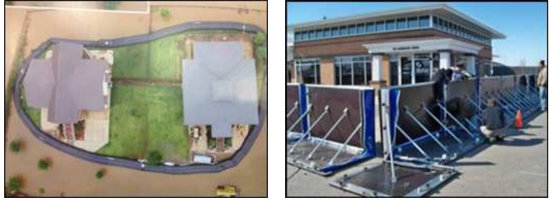
그림 1. Aqua Dam(미국)과 AquaFence(노르웨이) 차수막 사례
