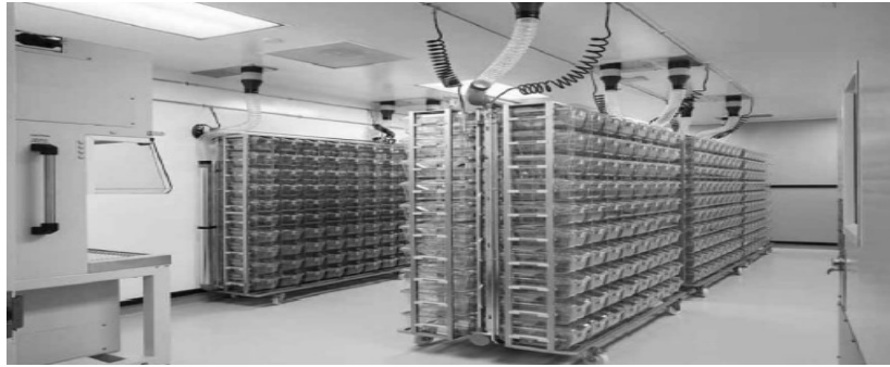
[그림-2] IVC(Individually Ventilated Cate) 시스템의 구축사례
