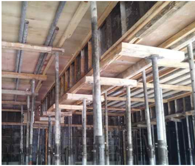
그림 1. 기존 거푸집 설치 3)
