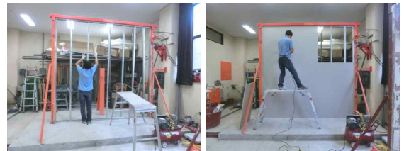
그림 1. 시험체 설치 전경
