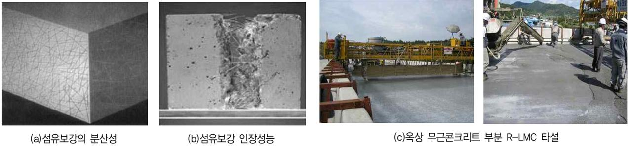
그림 1. 섬유보강콘크리트 균열저항형상 및 레미콘을 이용한 라텍스콘크리트 건축현장적용
