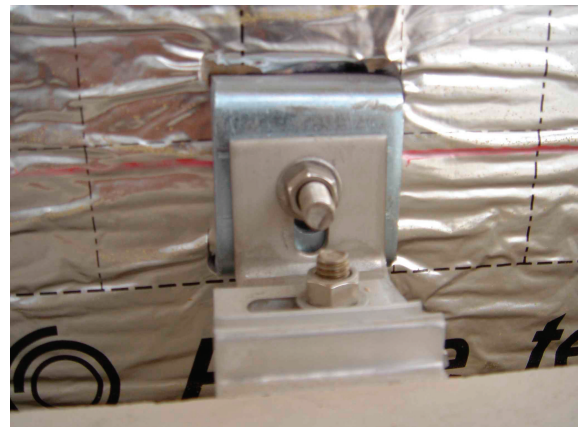
그림 2. 단열재 시공용 현장시공사례
