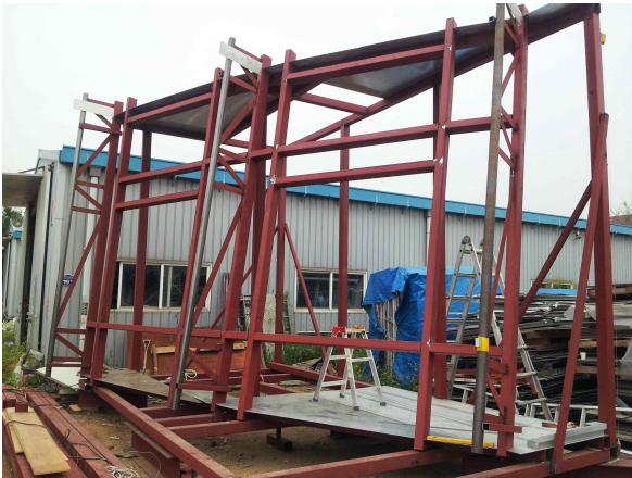
그림 3. Sub Structure 시공
