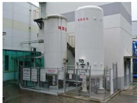
Fig. 2 LOx, LN<sub>2</sub> Storage Tank
