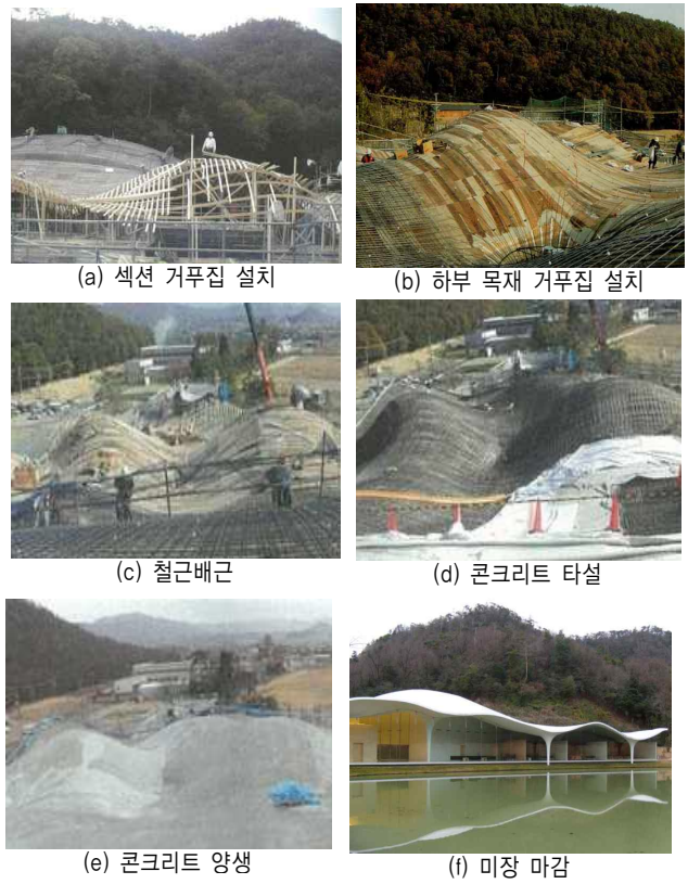
그림 4. CNC 가공된 섹션 거푸집 공법
