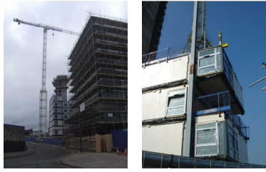
그림 1. Victoria Hall 학생기숙사의 시공전경 및 인필 내장모듈
