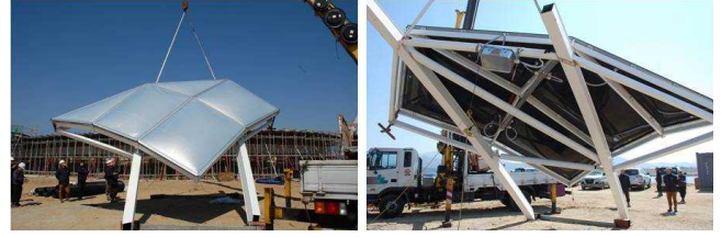
그림 3. 현장 구조-마감 MOCK-UP
