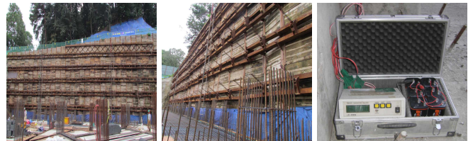
사진 1. 적용 현장 및 온도 측정
