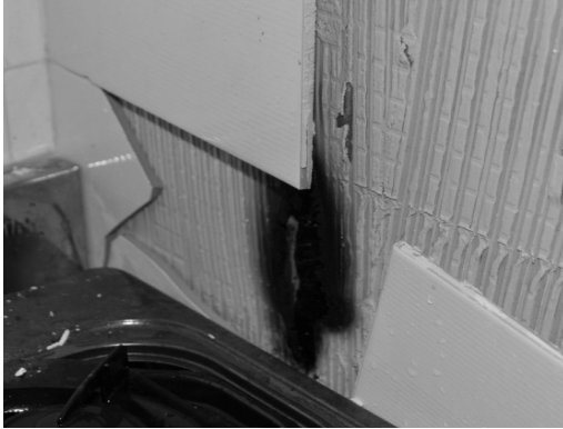
그림 1. 가스레인지 옆 벽의 타일제거후 모습
