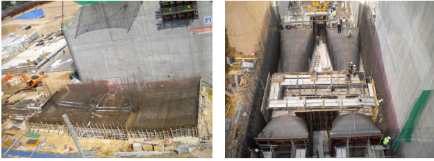
1. 기초 콘크리트 타설
