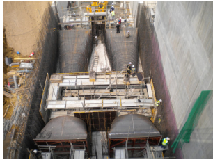
2. Draft Tube 설치
