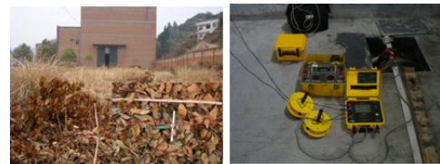
〈그림 7〉 접지저항 측정 사진
