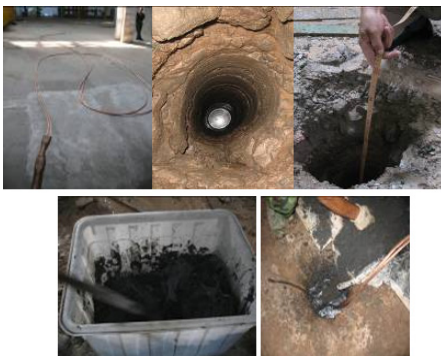
〈그림 5〉 접지전극 매설 사진
