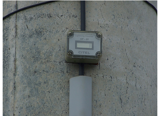
〈그림 6〉 낙뢰카운터기 동작 모습 (덕암 D/L 18호, default 5→ 8)
