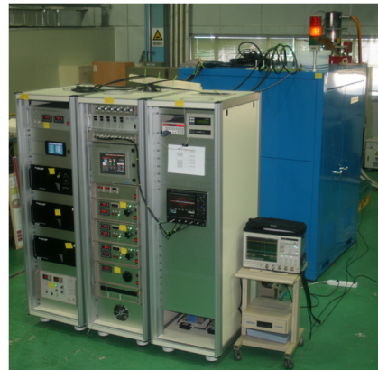
<그림 5> 고전압 전원공급장치 및 PLC 제어기
