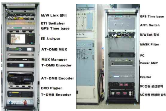
[ 그림 3. Head-end 시스템 및 AT-DMB 송신기 ]
