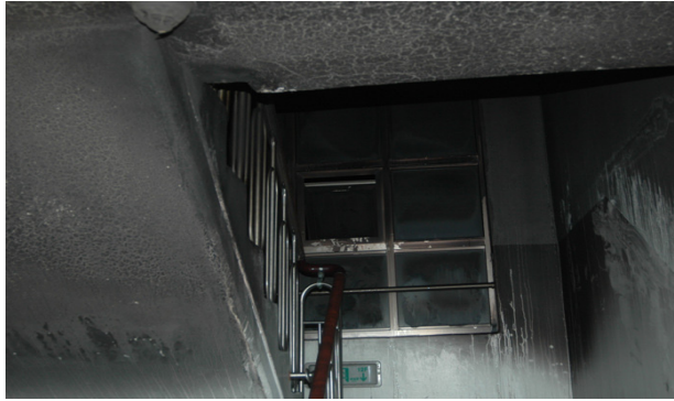
그림 2. 화재시 발생한 연기로 인한 계단그을음
