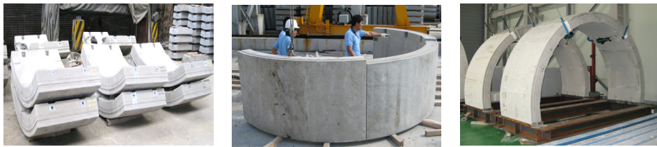
그림 1. 터널 라이닝실험체 제작 사진
