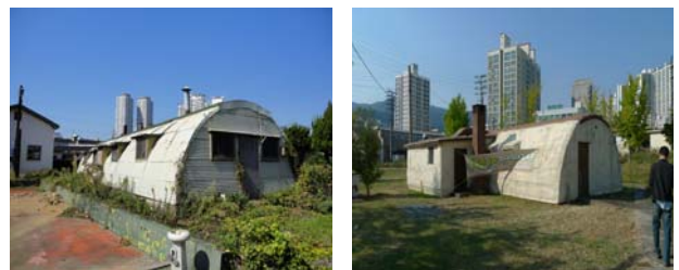
a) 1950년대의 원형이 보존된 퀘셋막사(T-292) b) 우레탄폼으로 도포된 퀘셋막사(T-522) 그림 3. 퀘셋막사의 보존 형태
