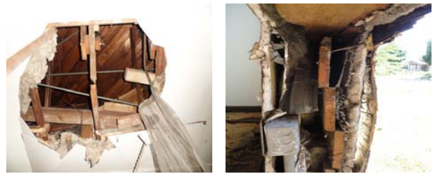
a) 소경재를 조합한 목조 트러스 지붕 b) 목재스터드 석고보드로 마감된 벽체 그림 2. 일본군 막사의 지붕 트러스 및 벽체 형태
