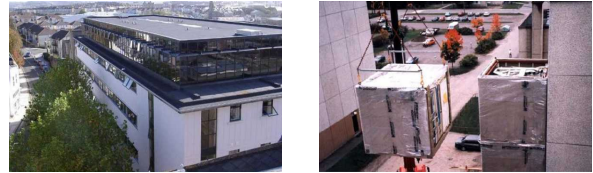
그림 2. 모듈러유닛을 이용한 리노베이션 사례, Over-Roofing(좌)
